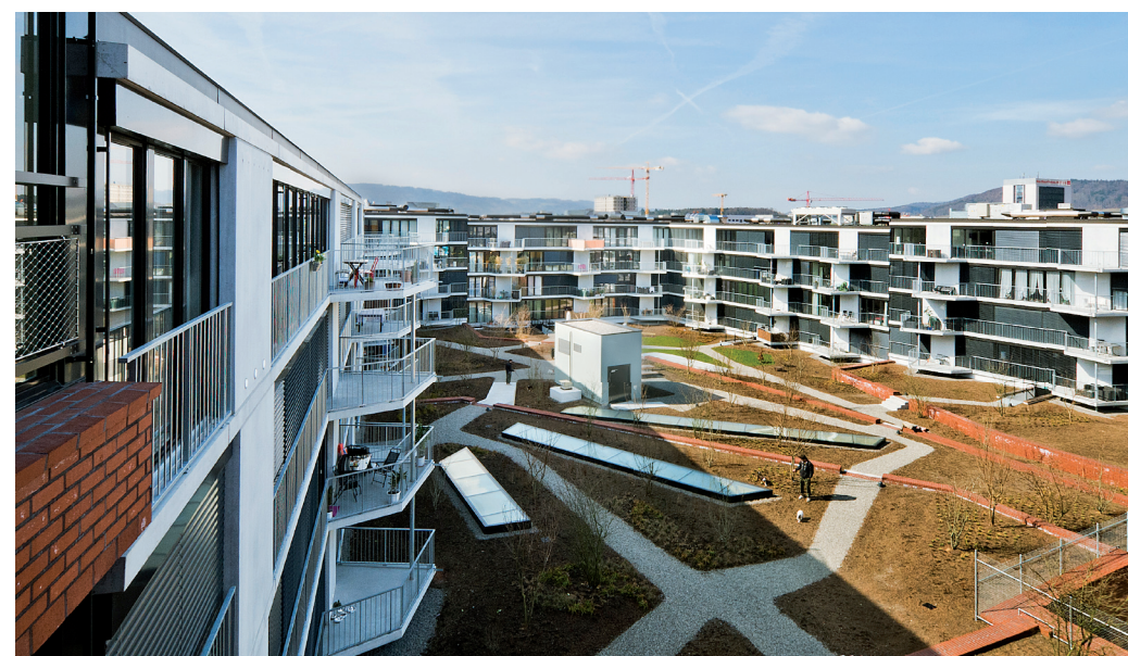
Parkside in Schlieren: Im Erdgeschoss befinden sich rund 20 Läden, darüber Büros und knapp 100 Wohnungen.
